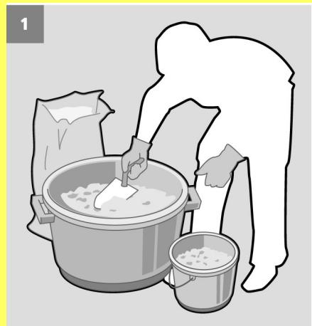
Das Verhältnis Zement/Sand/Kies für Beton ist 1:2:3. Mischen Sie also 1 Teil Zement, 2 Teile Sand und 3 Teile Kies. Ein Teil ist zum Beispiel eine Schaufel, ein Eimer oder ein Sack. Die benötigte Menge an sauberem Wasser ist nicht genau zu beziffern, weil diese von der jeweiligen Sorte Zement, Sand und Kies die Sie verwenden, abhängig ist.
