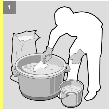
La proporción cemento/arena/grava para hormigón es de 1:2:3. Mezcle una parte de cemento, 2 partes de arena y 3 partes de grava. Una parte puede ser la cantidad de una pala, un cubo o una bolsa. La cantidad de agua limpia es variable, ya que depende del tipo de cemento, arena y grava que se usa.
